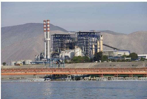
Desalinizadora, bahía Mejillones
