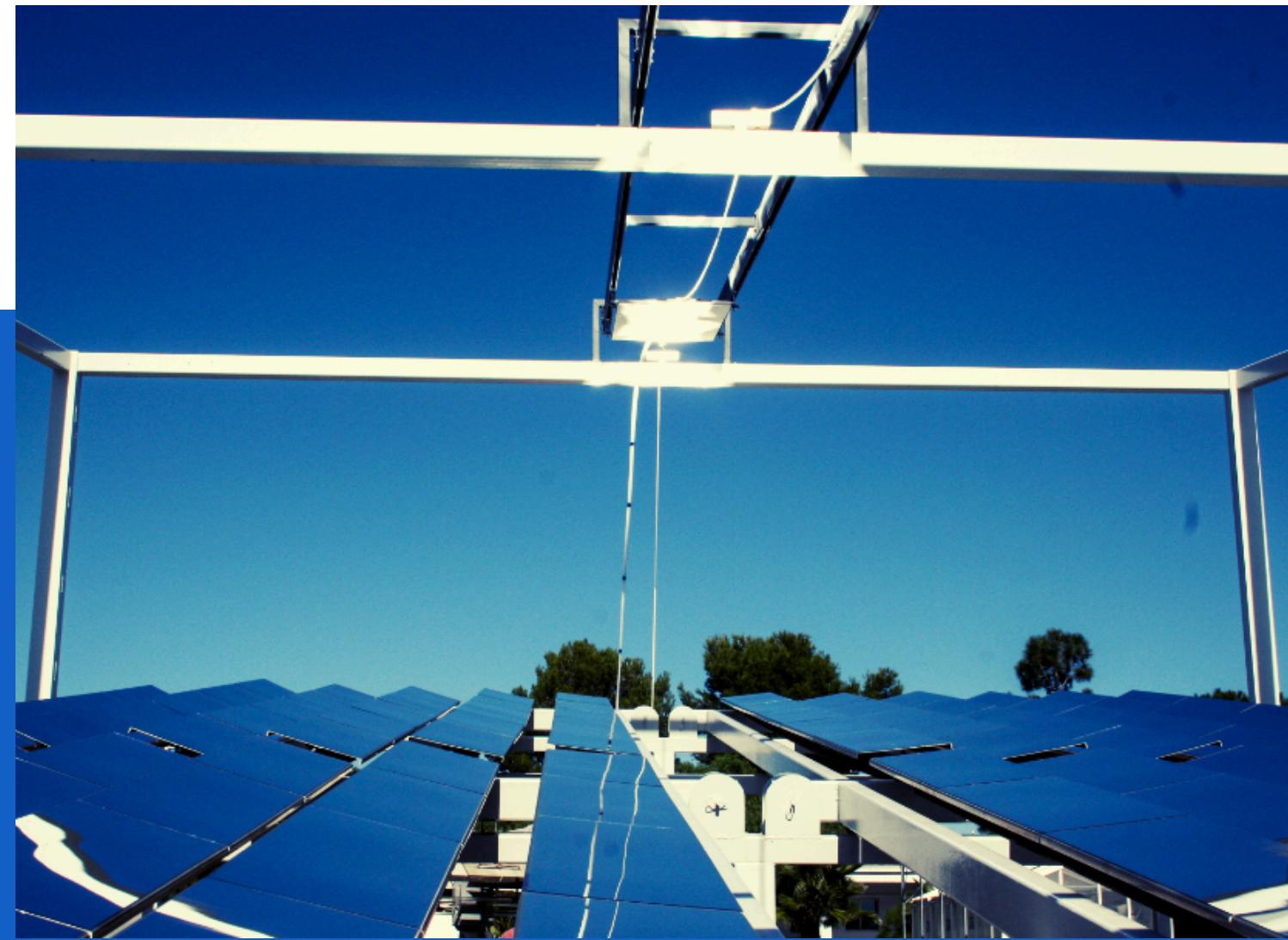
Entre los beneficios de la tecnología se destaca el incremento del rendimiento óptico de los captadores tipo Fresnel para potenciar su uso. Suministra calor a procesos industriales a partir de energía solar térmica de concentración. Es un sistema escalable compacto y único, y posee amplio rango de latitudes geográficas.
